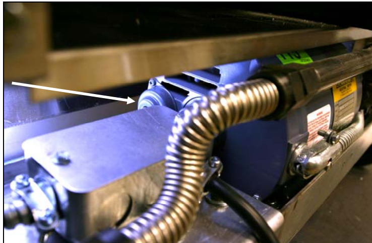
Resetschakelaar van filterpomp (pijl)
